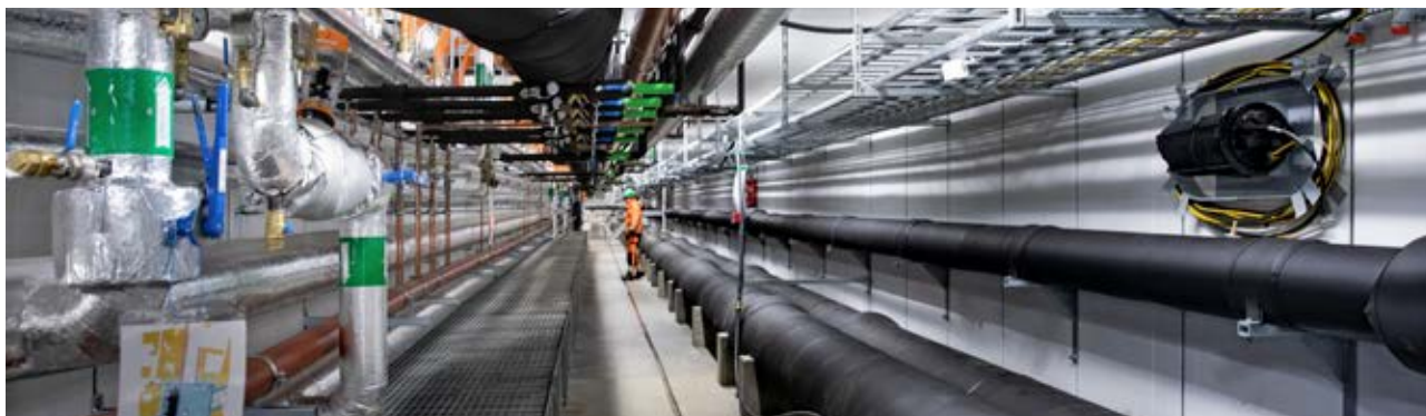
Gangbar kulvert under Trondheim torg som blant annet rommer omlegging av eksisterende anlegg for vann, avløp, strøm, telefon og fjernvarme.
